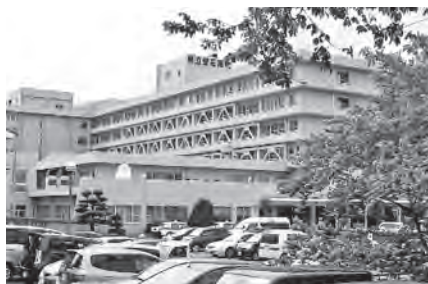
県立釜石病院
